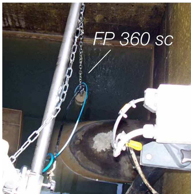
Figura 1. Instalación de la sonda aceite en el agua FP 360 sc en la cámara de inspección después del separador de aceite/agua
